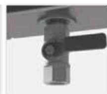
Robinet de purge
